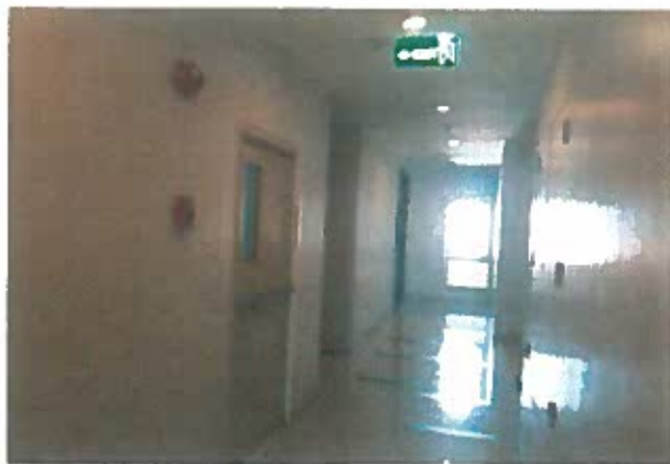
กริ่งสัญญาณเตือนภัย เครื่องแจ้งเหตุ โดยใช้มือดึง
