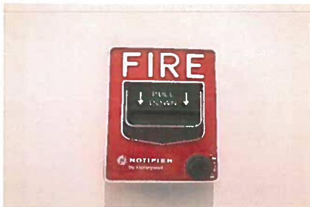
กริ่งสัญญาณเตือนภัย เครื่องแจ้งเหตุ โดยใช้มือดึง
